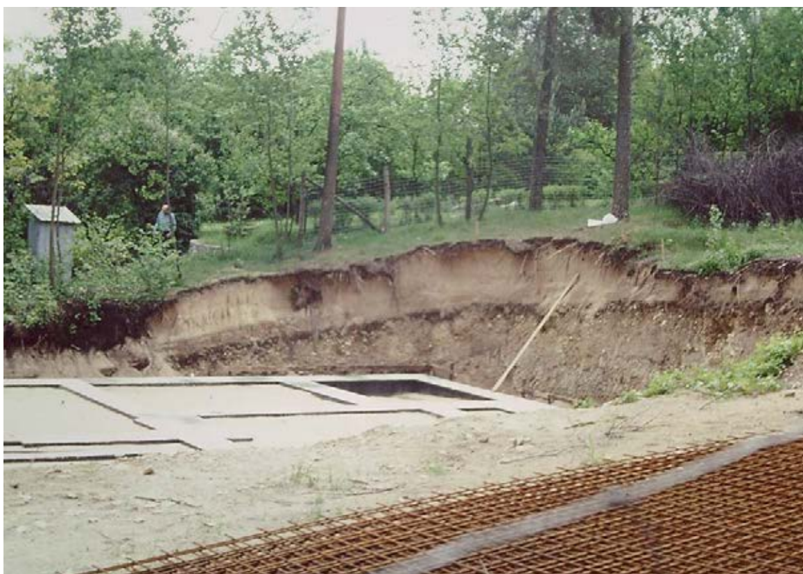
Ryc. 1.2.3. Olkusz – Czarna Góra. Na przekroju wykopu pod dom mieszkalny widoczny jest poziom glebowy przykryty nawianym piaskiem. Fot. D. Rozmus
