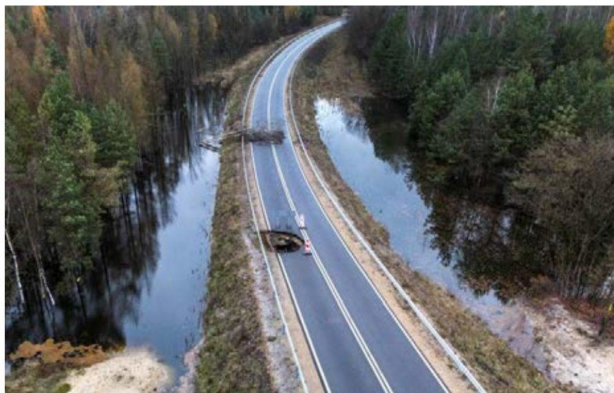
Ryc. 1.3.9. Zapadająca się i pod- tapiana obwodnica Bole- sława pod Olkuszem. Fot. F. Rozmus
