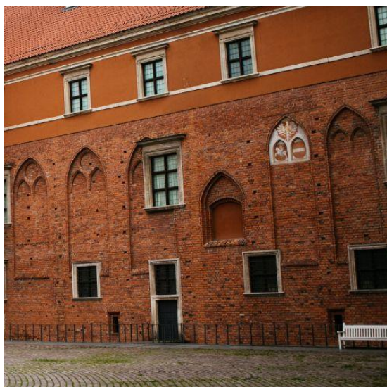
Zamek Królewski w Warszawie rekonstruowane reliktu tzw. Domu Wielkiego
